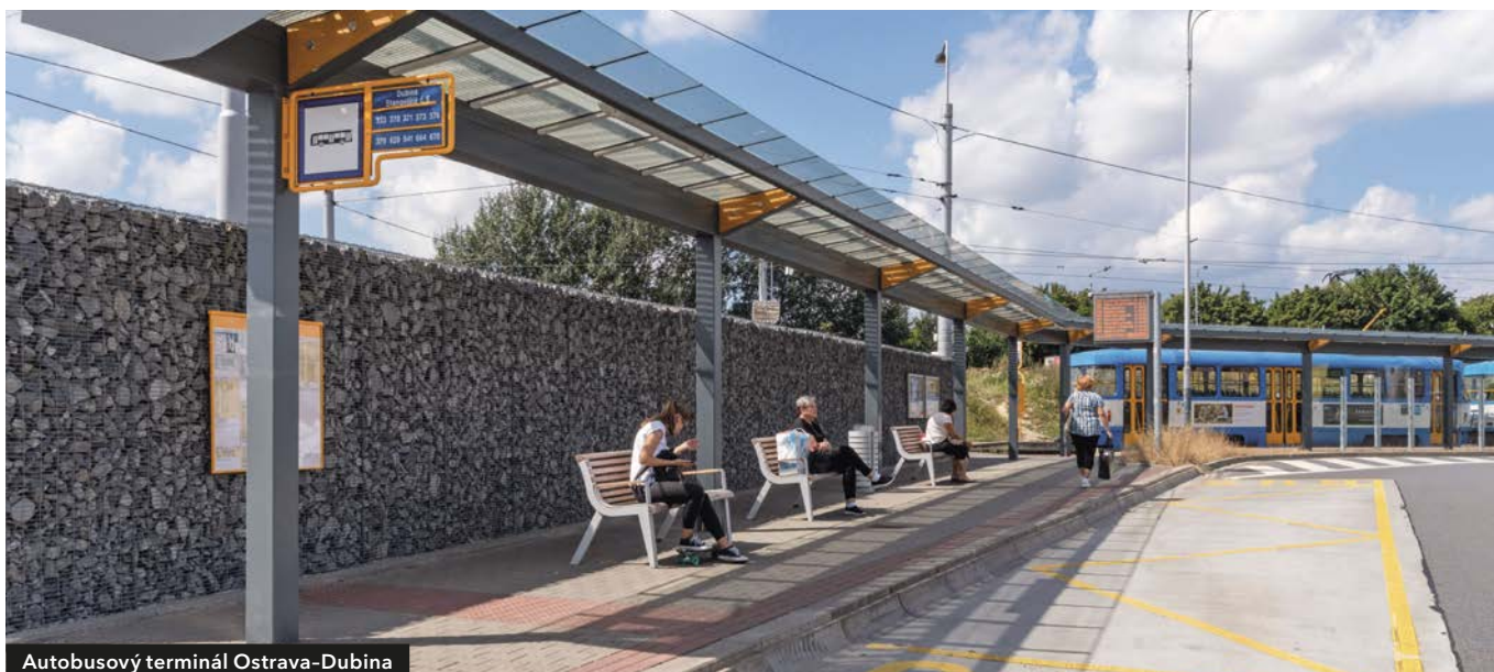
Autobusový terminál Ostrava-Dubina
