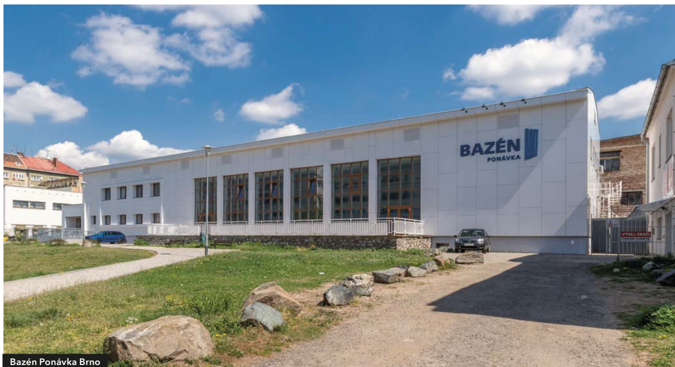
Bazén Ponávka Brno
