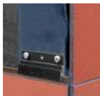
OTEVŘENÁ ROHOVÁ SPÁRA S TĚSNĚNÍM EPDM Obr. 2
